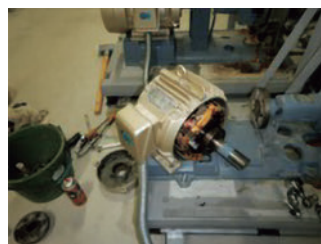
（左）冷温水ポンプベアリング交換
