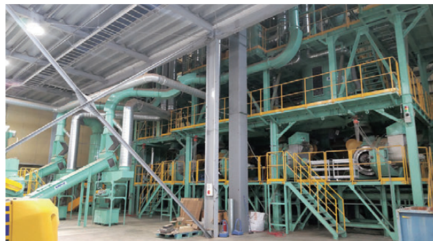
(上) 6月から稼働した新工場
